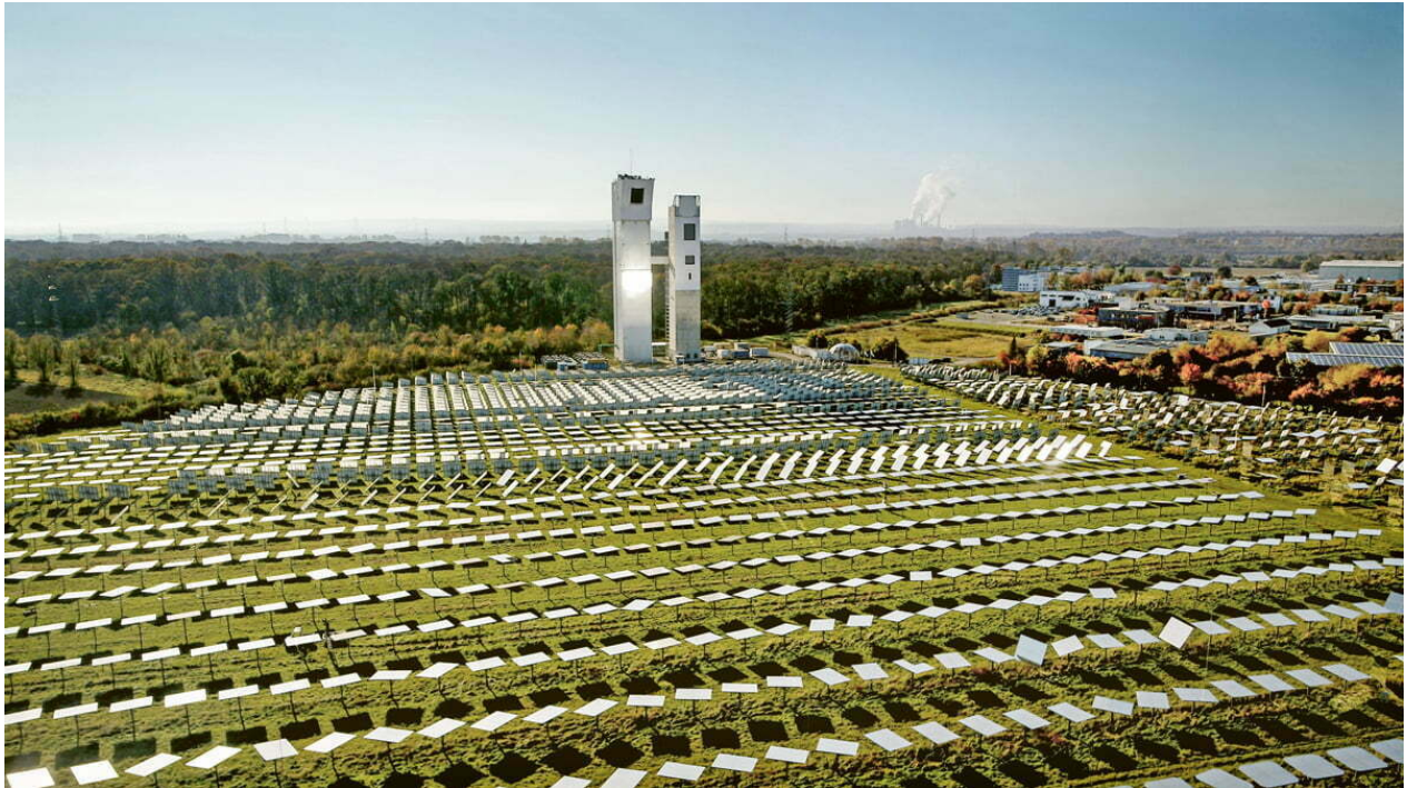
Testanlage im Solarturm des Deutschen Zentrums für Luft- und Raumfahrt: Der Receiver im Turm absorbiert die vom Spiegelfeld reflektierten Sonnenstrahlen und treibt den Reaktor an.
