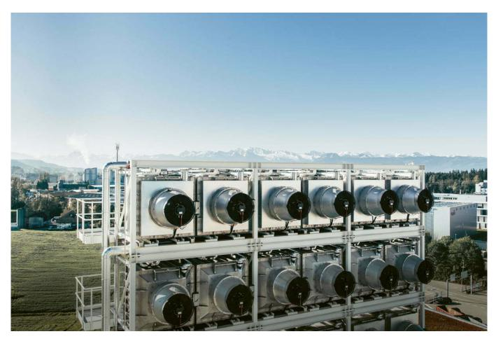
Das ETH-Spin-off Climeworks ist ein wichtiger Player im stark wachsenden globalen Markt rund um das Direct Air Capture genannte Verfahren, bei dem CO2 aus der Atmosphäre gefiltert und im Boden gespeichert wird. Im Bild eine Anlage in Hinwil.
